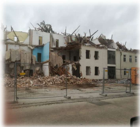
Abriss des Blocks U 13 (AusbKp 3/1 und Fahrschule)
